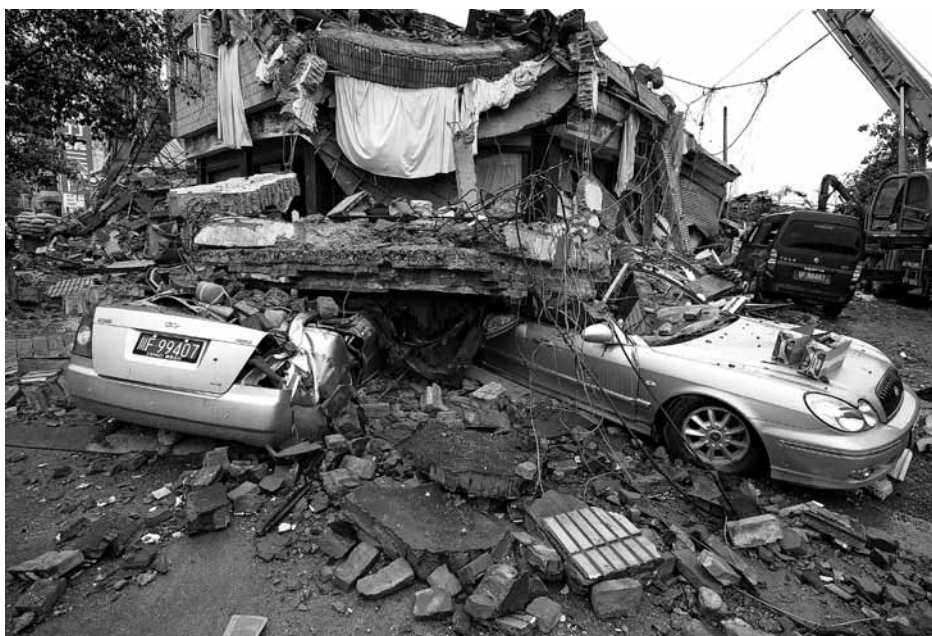
▲ 2008 年 5 月 13 日，距離四川汶川地震震中直線距離約 30 公里的綿竹市漢旺鎮受損嚴重。
